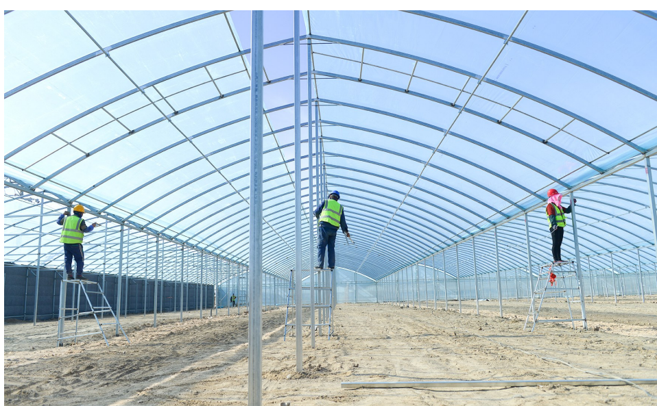
4月10日，在新城镇戈壁农业示范园区智慧种植基地建设现场，工人正在进行钢架大棚架配作业。
