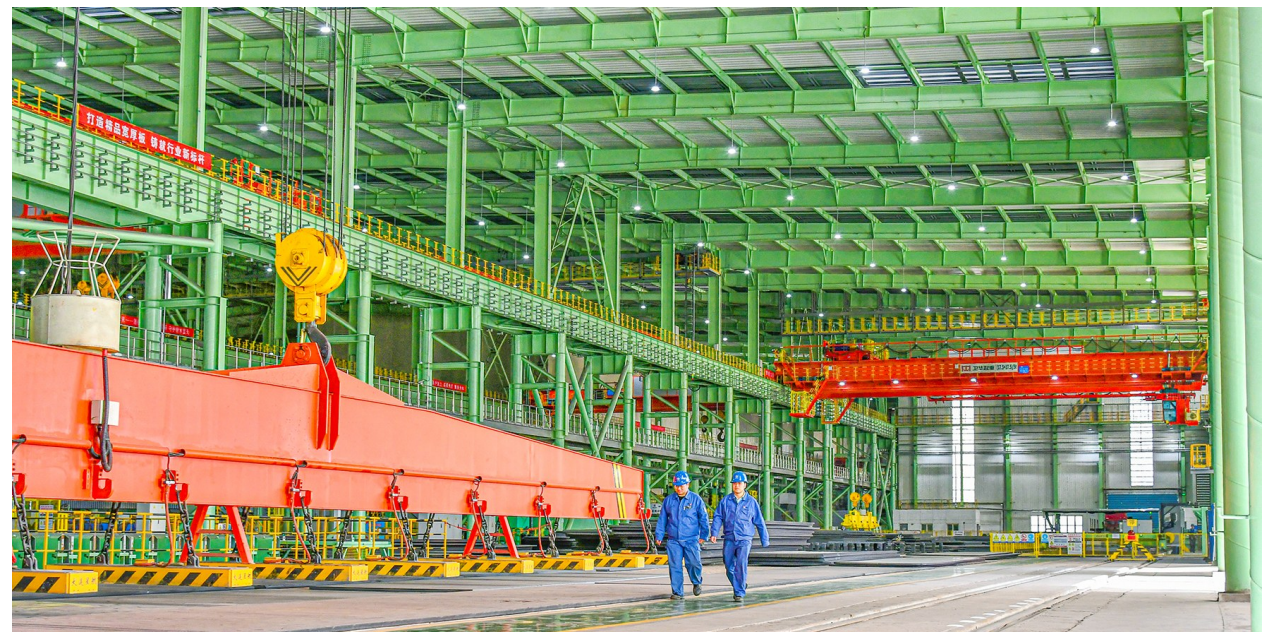
图为酒钢集团宏兴宏博新材料公司生产车间
