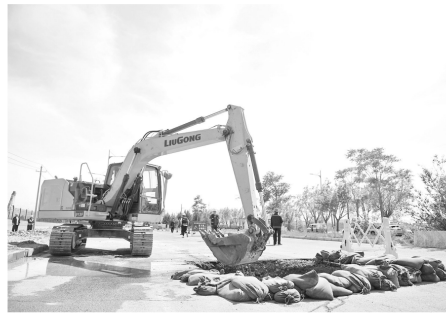
这是演练中清理路基下陷处杂物。 融媒体中心记者 高深 摄
