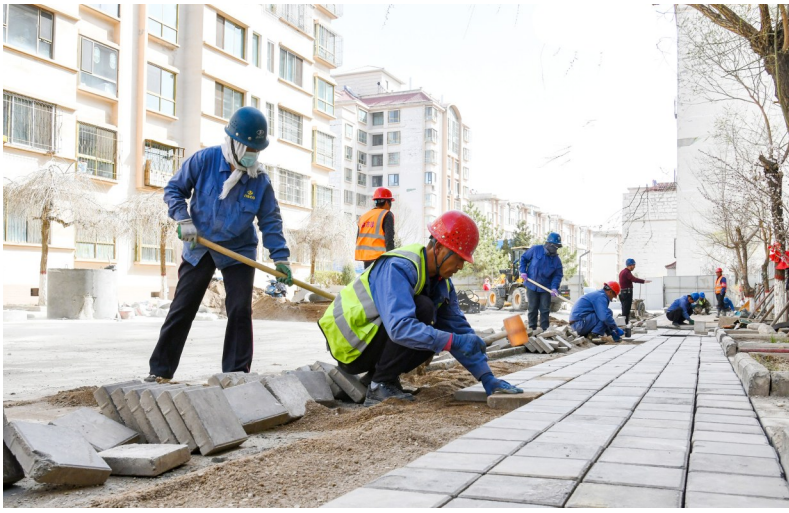
作业工人对小区内拆除的花砖重新铺设
